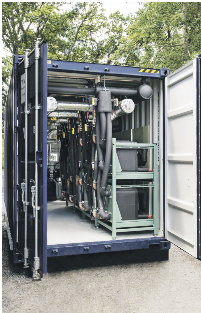
Insidan på en Energy-in-a-Box. Sonority's paketerade geoenergi-central.
